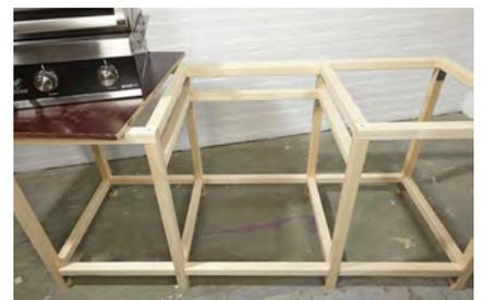
12. Blick auf die Unterkonstruktion aus Rahmenhölzern rund um den Einbaugrill.
