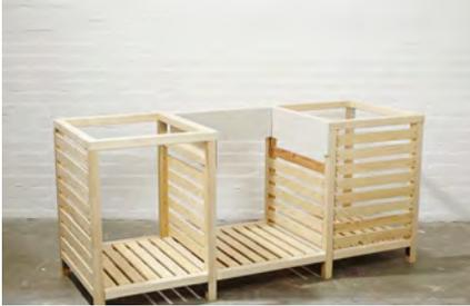
**22.** Nach diesem Prinzip wird die Verkleidung an alle geschlossenen Korpussteile montiert: Leisten anbringen, Verkleidung aufschrauben. Die Rückseiten bleiben offen.
