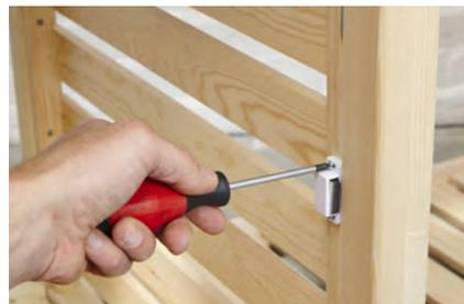
**26.** Ein aufgeschraubter Magnetschließer fixiert die Türen im geschlossenen Zustand.
