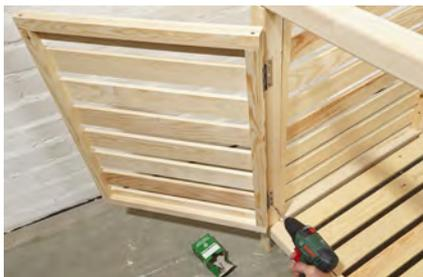
**25.** Die Türen mit Scharnieren an den Korpus montieren.
